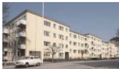
Jerusalem 2 , Levertinsgatan 1–5. På krönet av branten mot Tranebergssund ligger längan från 1931. Trapphusen ligger i husets mitt med takljus. På varje halvplan når man lägenheter, vilket har gett byggnaden varierad takhöjd. Foto Anna Ulfstrand 1985.
