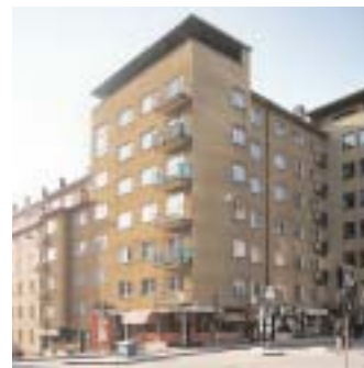
Pontonjärkasern 12 , Hantverkargatan 61, Polhemsgatan 15, 17. I denna tydligt markerade hörnbyggnad från 1935 har Hedvall använt typiska funktionstribut såsom bottenvåningens pelare klädd i rostfritt stål och en takaltan, här med ett skärmtak som ger byggnaden dess särprägel. Foto Ingrid Johansson, 1980-talet.
